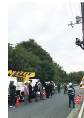
高所作業見学
